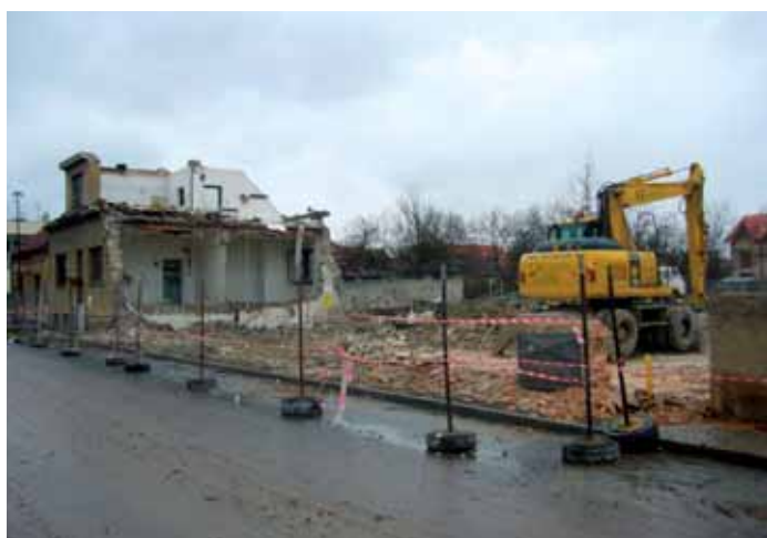
Bourání staré tělocvičny v Unhošti
