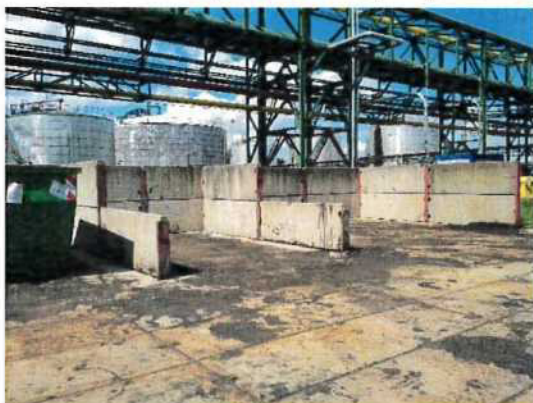
Foto č. 2 Prázdné betonové kóje na místě zvaném „ blok 42 - Shromaždiště pevného odpadu “
